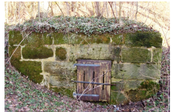
Die Brunnenstube (F)
